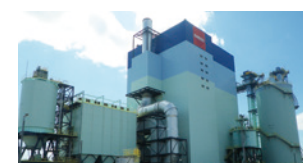
室蘭バイオマス発電所
